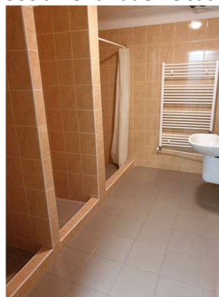
Sociálne zariadenie šatní
